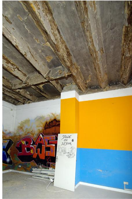
Abb. 7: Deckenansicht im Raum im zweiten Obergeschoss. Im Anschluss zum Kaminschacht ist ein Wechsel für den ursprünglich deutlich größeren Kaminschacht erkennbar. (Aufnahme: M. Kessler, Februar 2016).
