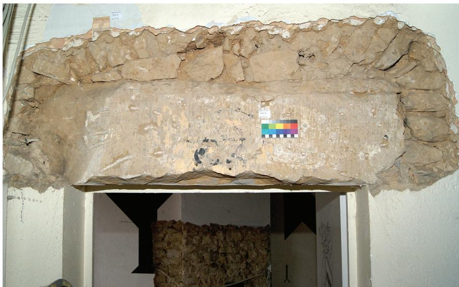
Abb. 4: Sturz der Türöffnung zum Raum im zweiten Obergeschoss. Der Stein wurde nachträglich abgeschlagen, um die Türöffnung zu erweitern (Aufnahme: M. Kessler, Februar 2016).
